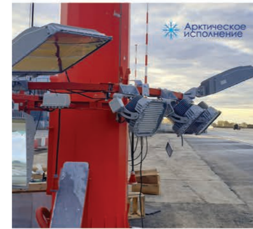
СВЕТОДИОДНЫЕ ПРОЖЕКТОРЫ работают при температуре от -60 до 55 °С
