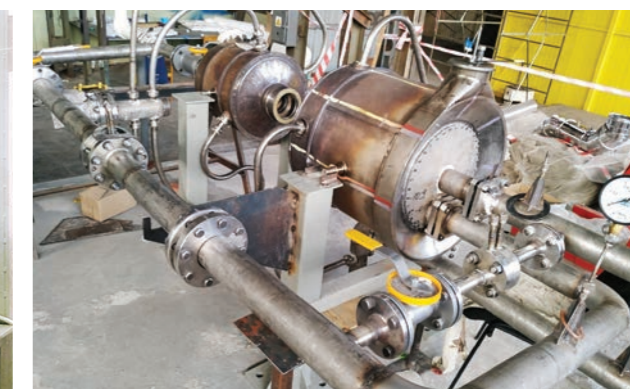
Рис. 3. Монтаж стенда рекуператоров
