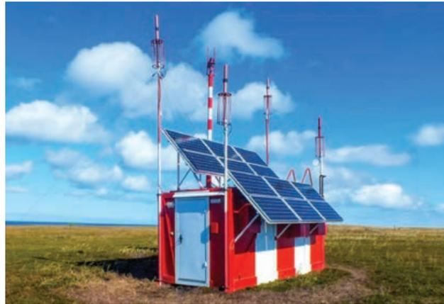
ных цепей, подготовленными для сборки на месте монтажа. Каркас выполнен из стальных труб прямоугольного сечения. Конструкция и размещение боковых вертикальных стоек каркаса, стальных балок, интегрированных в пол модуля, выполнена с учетом установки на них технологического оборудования. Габариты контейнеров обеспечивают возможность транспортировки автомобильным транспортом по дорогам общего пользования без специальных разрешений и пропусков. Срок службы контейнеров составляет не менее 20 лет.
