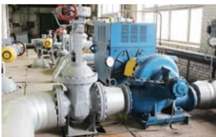
ячейками, напорными затворами насосных агрегатов осуществляется от программируемого логического контроллера. Задание уставки давления, задание режима циркуляции, отображение состояния оборудования и хода технологического процесса осуществляется на графической панели поста оператора.
